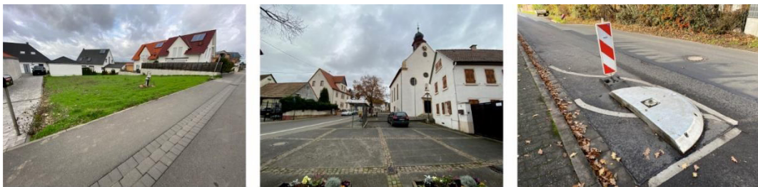
Abbildung 23: Baulücke, Kirchplatz und unattraktiv gestaltete Fahrbahnverengung
