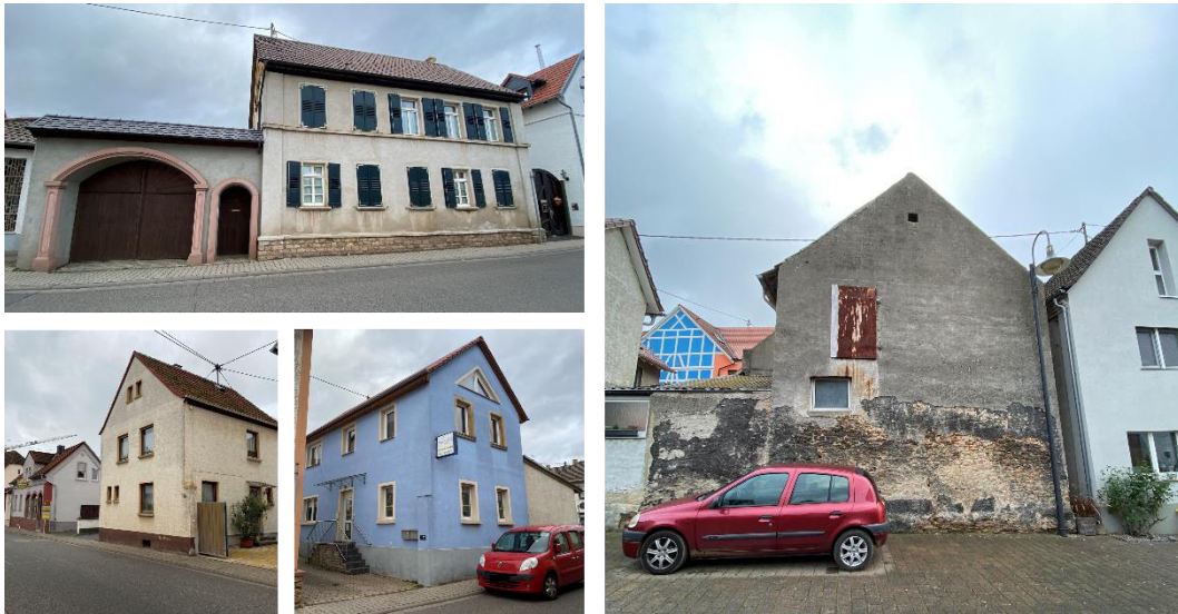
Abbildung 21: Bsp. Gebäude mit Sanierungsbedarf im Altortbereich
