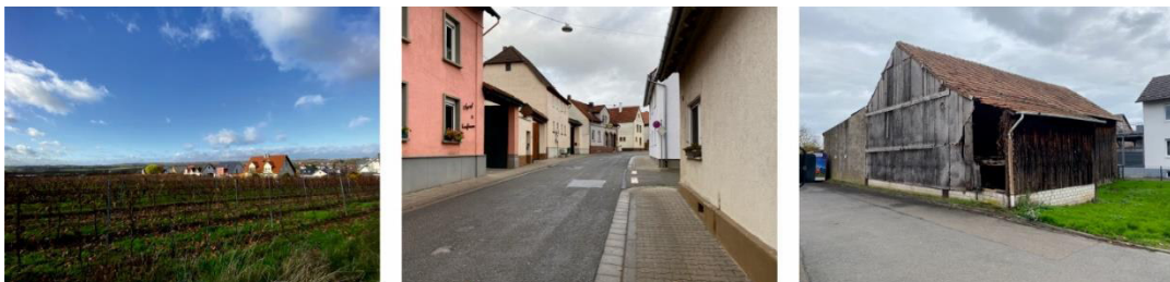
Abbildung 22: Weinbaulandschaft, Mommenheimer / Bahnhofstraße und sanierungsbedürftige Scheune
